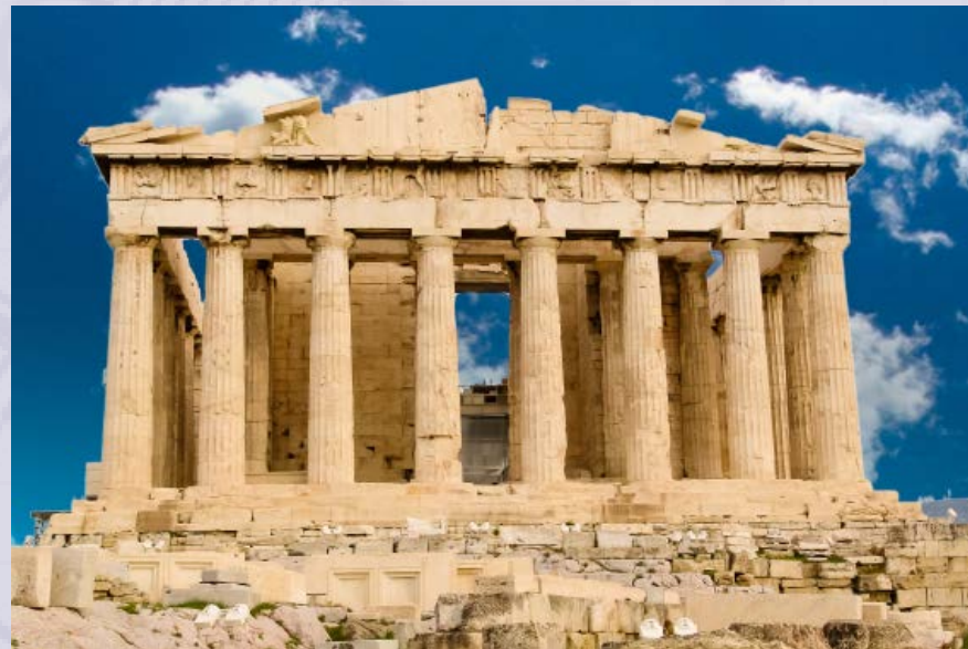
Veduta classica del Partenone con le otto colonne doriche sulla facciata.
